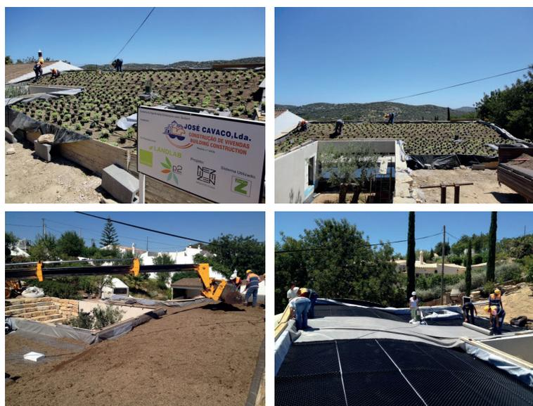
Figura 2 Etapas da construção de uma cobertura verde de José Cavaco, Lda. Neoturf. FOTOS: Landlab.
