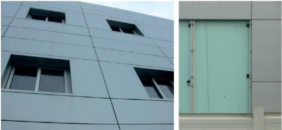
**Figura 1** Fachada ventilada com isolante na caixa-de-ar.
