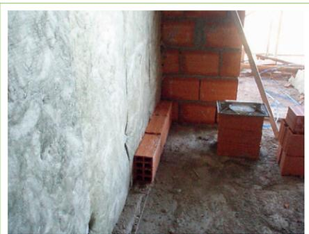
**Figura 2** Colocação (errada) de material absorvente sonoro em parede dupla.
