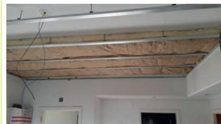
Figura 3 Isolamento sob laje esteira.
