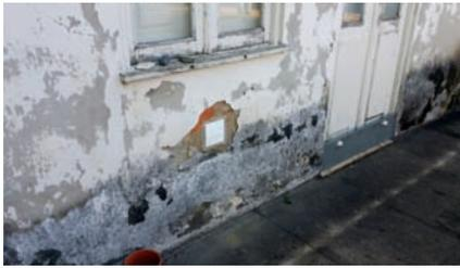
**Figura 3** Humidade ascensional e reboco destacado.
