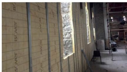
Figura 2 Isolamento parede alvenaria pedra.
