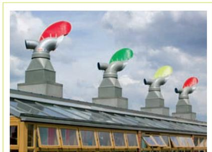
**Figura 4** Dispositivo de ventilação natural com recuperação de calor e orientável com o rumo do vento.
