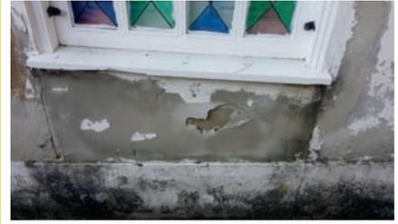
**Figura 2** Reboco destacado - argamassas de base cimentícia.
