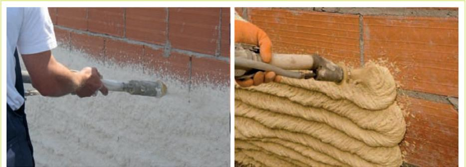
**Figura 7** Reboco térmico projetado.
