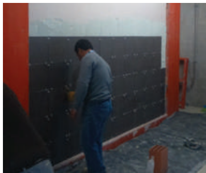
Figura 4 - Aplicação do revestimento cerâmico no provete (3.16 m x 3.16 m) destinado à caracterização acústica
