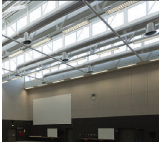
OM2A - O'Neill Mendes Arquitectos Associados Lisboa, Portugal
