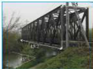
[b] Conexão de 22 perfis em comprimento total de 46,2 m, altura de 6,8 m e largura de 2 m, em construção concluída a 10°
